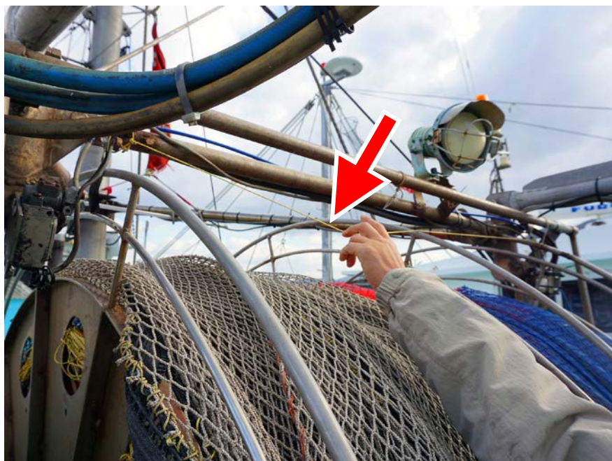
非常停止装置の設置例①
