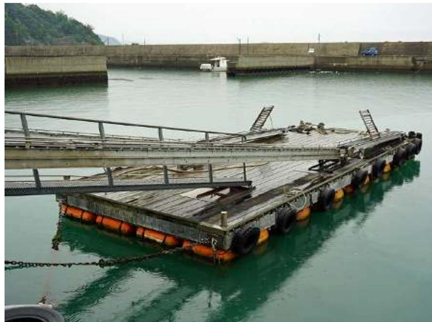
コンベア設備を搭載した浮き桟橋の例
