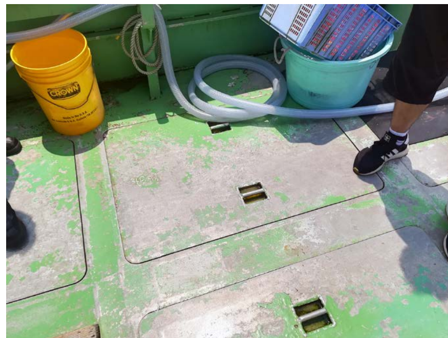
段差の少ない甲板の例②
