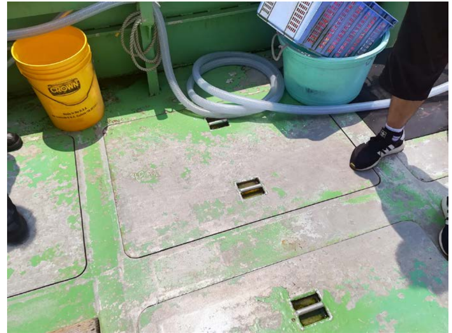
段差の少ない甲板の例②
