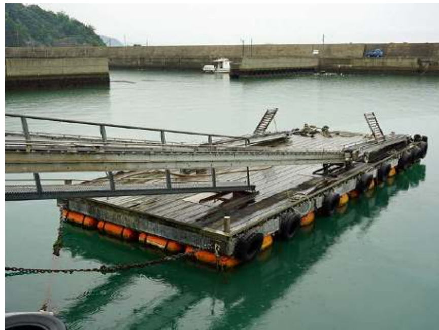
コンベア設備を搭載した浮き栈橋の例
