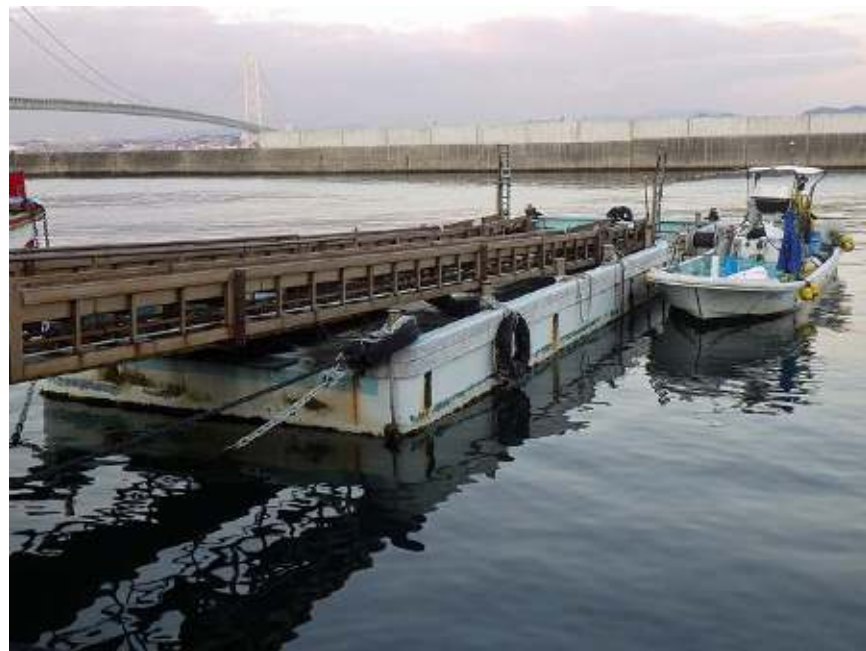
コンベア設備を搭載した浮き栈橋の例
